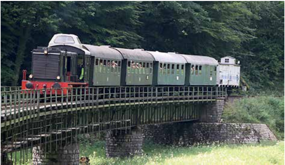
Abb. 10 Die Museumseisenbahn überquert die Hindenburgbrücke. Foto: Löwisch
