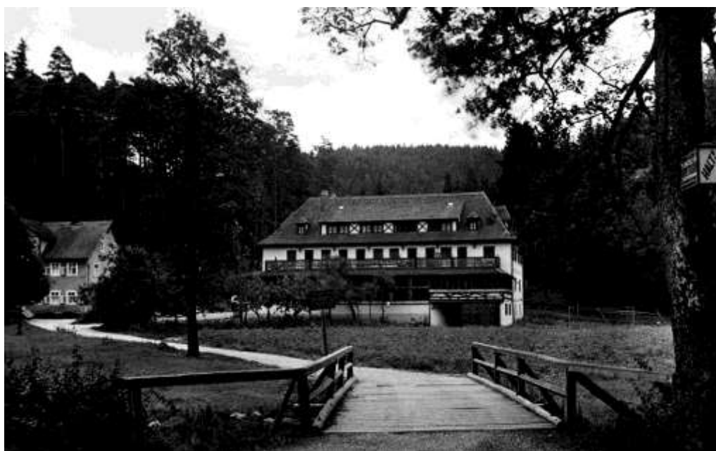
(Bild: Der Zugang zur Pulvermühle über die hölzerne Brücke. Rechts das GÄSTEHAUS, in dem die Lesungen stattfanden. Links das Gasthaus)
